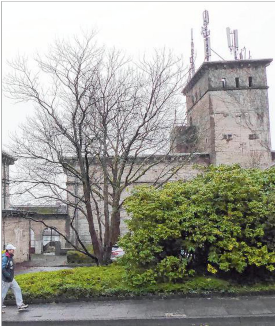
Für den Umbau dieses Bunkers an der Siegener Burgstraße zur Erweiterungsfläche für das Siegerlandmuseum ist ein Antrag auf Förderung gestellt worden. Archivfoto: kalle
